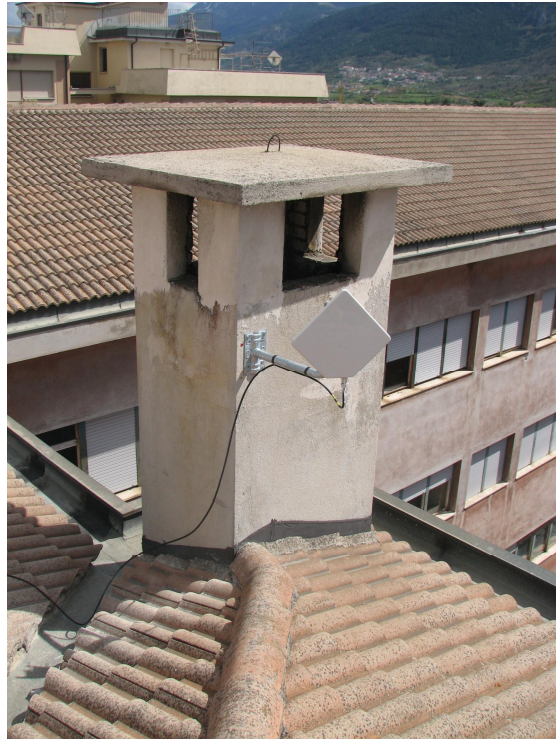
Figura 11 – Tipica installazione a pipa (Radio + Antenna in 1 unica soluzione)
